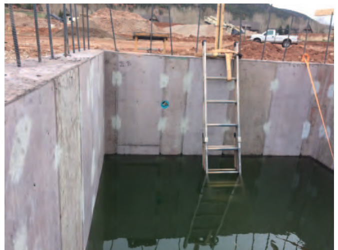
Fig. 8 : l'essai hydrostatique a réussi du premier coup.
