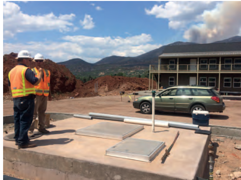
Fig. 6 : un couvercle d'env. 25 cm d'épaisseur doté de trappes d'accès est réalisé en béton coulé sur place.
