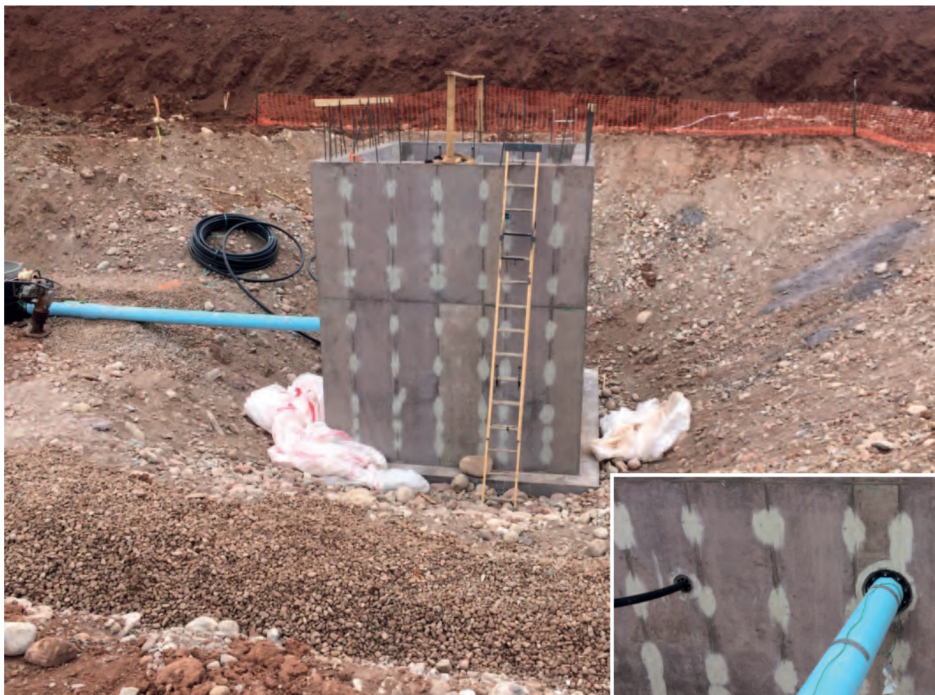
Fig. 4 : la nouvelle station de relevage en béton coulé sur place fait partie du réseau d'égout pour l'extension du club exclusif Roaring Fork à Basalt dans l'état américain du Colorado. Le produit d'étanchéité cristalline et adjuvant antimicrobien Xypex Bio-San C500 a été ajouté au béton prêt à l'emploi pour la nouvelle station de relevage. On distingue à droite le tuyau d'alimentation de 8 pouces (voir petite photo) vers la station de relevage, ainsi que la conduite d'écoulement de sortie de 2 pouces.
